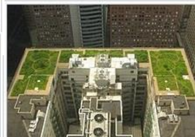
Zelená střecha na budově radnice v Chicagu
