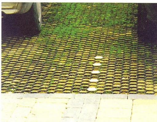
Obr. 28: Odstavná plocha s trávníkovými voštinami – s povrchovou protierozní ochranou (počínající zazelenění)
