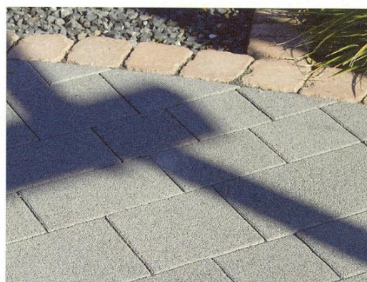
Obr. 31: Betonová dlažba z mezerovitého betonu
