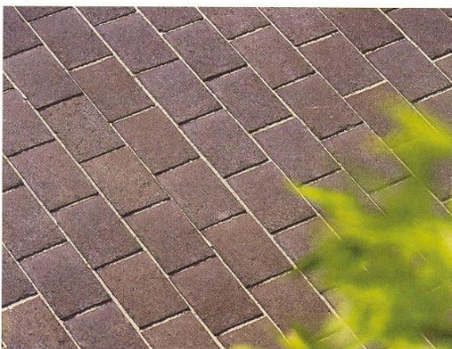
Obr. 30: Betonová dlažba s drenážními spárami
