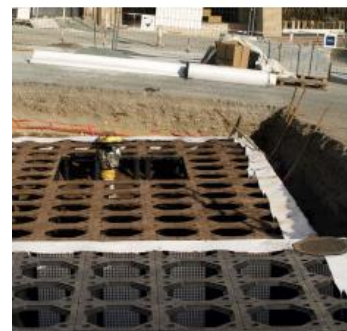
549 Domínkánské náměstí, Brno, prokořefující tvarovky
