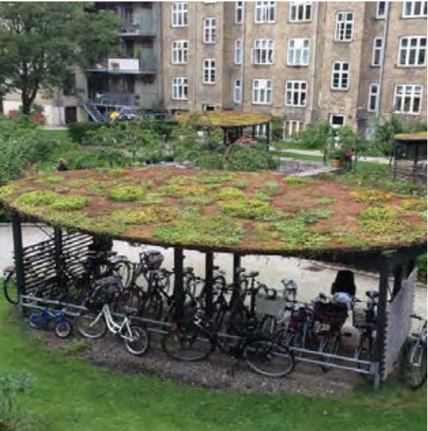
extenzivní vegetační střecha
