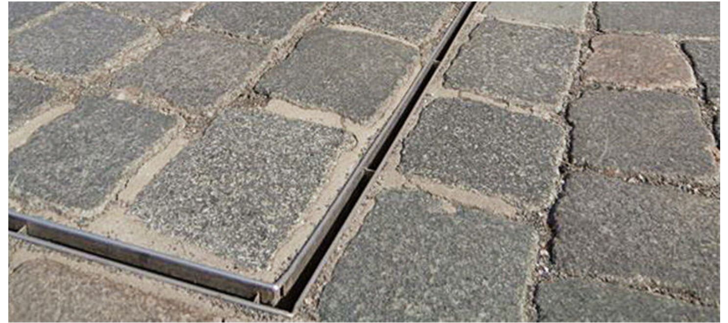
Použití štěrbinového žlabu
