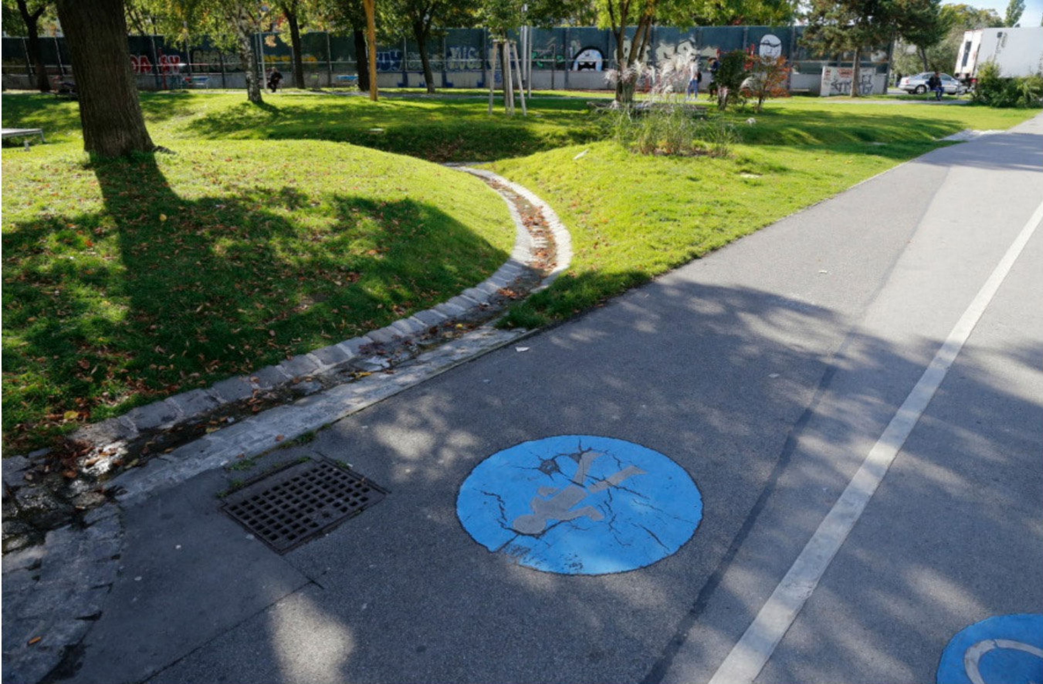
Šachta je opatřena klapkou, která je v létě zavřena, a dešťová voda je odváděna do vsakovacího průlehu v parku Bruna Kreiského. (Foto J. Vítek)
