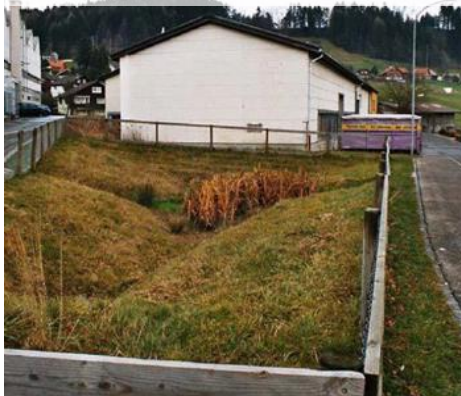
Nádrž na srážkovou vodu
