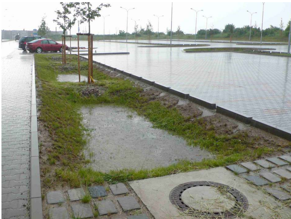
Vsakovací průleh k odvodnění parkoviště. (Foto: JV PROJEKT VH s.r.o.)
