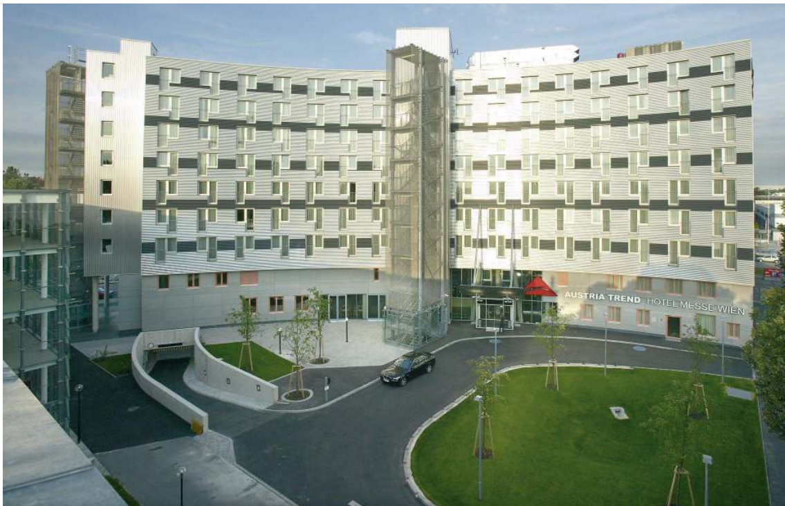
Zasakovací průleh na povrchovou vodu s podzemními vsakovacími šachtami na dešťovou vodu. (Foto: Austria Trend Hotel Messe Wien)
