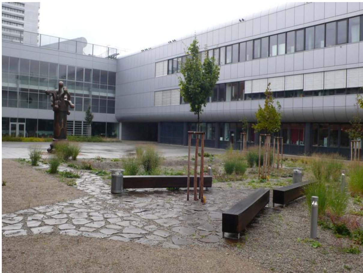
AVVA - MODRÁ (Akademicko výzkumný a vývojový areál – etapa modrá) zasakovací průleh. (Foto: JV PROJEKT VH s.r.o.)
