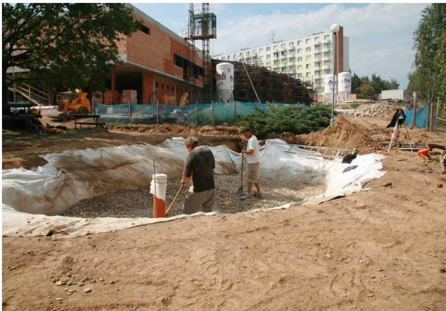
Vsakovací průleh během realizace. (Foto: JV PROJEKT VH s.r.o.)
