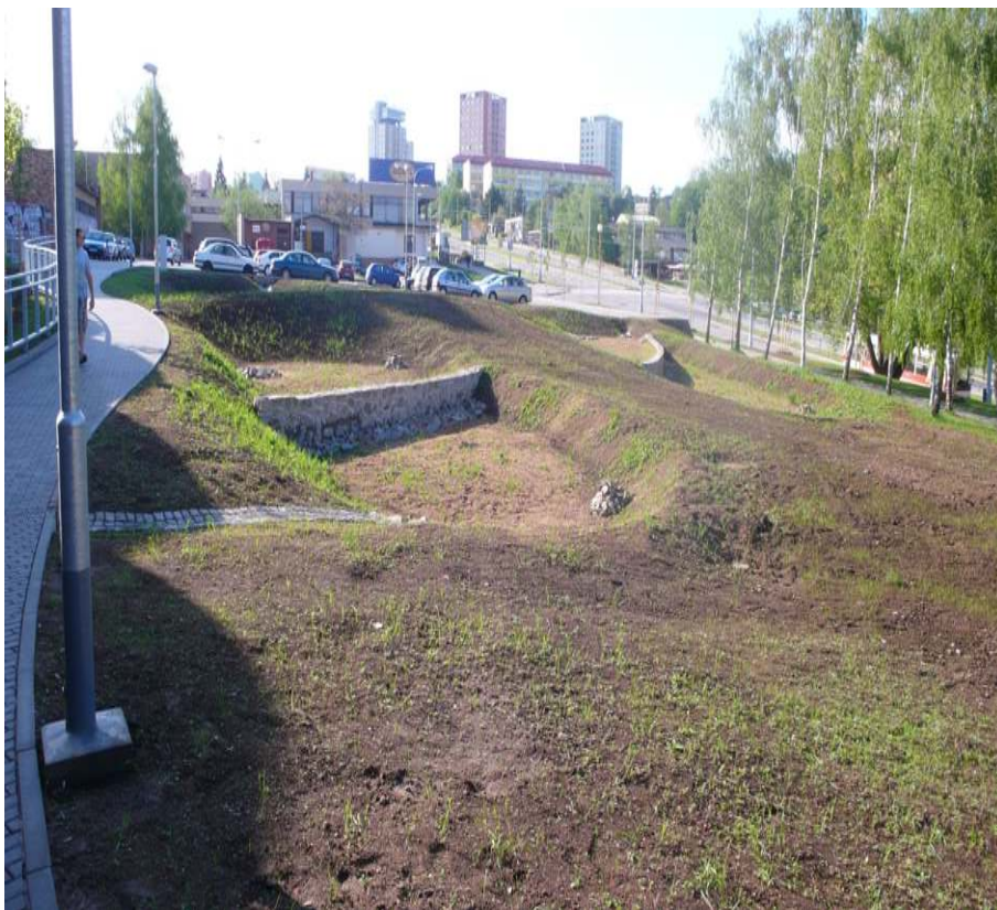
Vsakovací průleh po dokončení. (Foto: JV PROJEKT VH s.r.o.)
