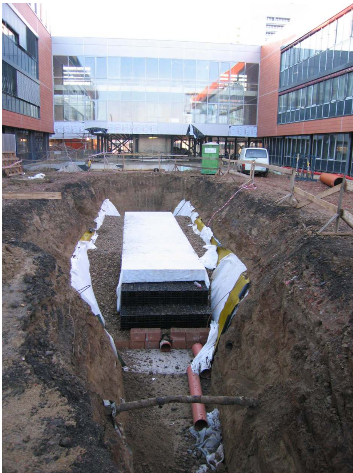
AVVA - MODRÁ (Akademicko výzkumný a vývojový areál – etapa modrá) zasakovací průleh. (Foto: JV PROJEKT VH s.r.o.)
