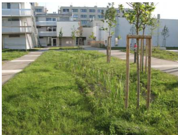
Záhon s rákosem pro zasakování povrchové vody. (Foto: Büro Grimm)
