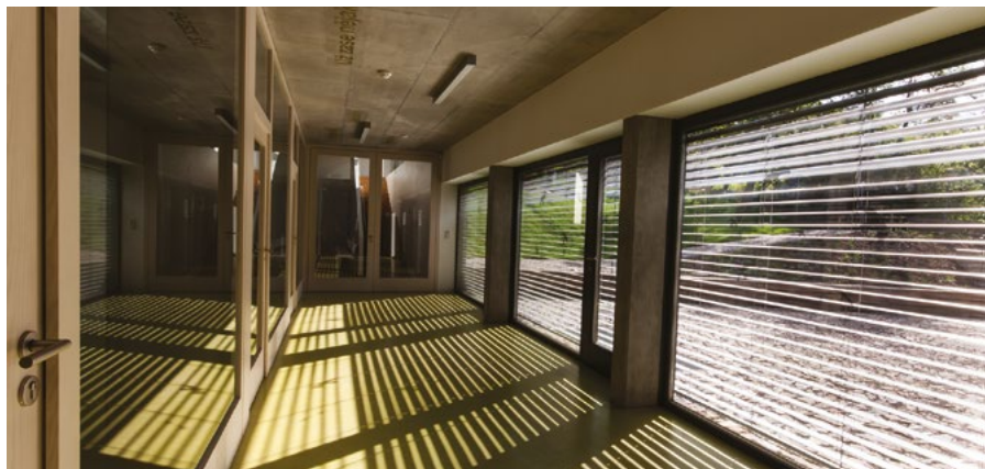
V budově Otevřené zahrady využívají pro chlazení i topení rozvody zabudované ve stropě, tzv. aktivovaný beton.
