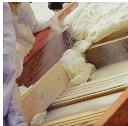
Během zateplování střechy není soukromí obyvatel domu nijak narušeno.
