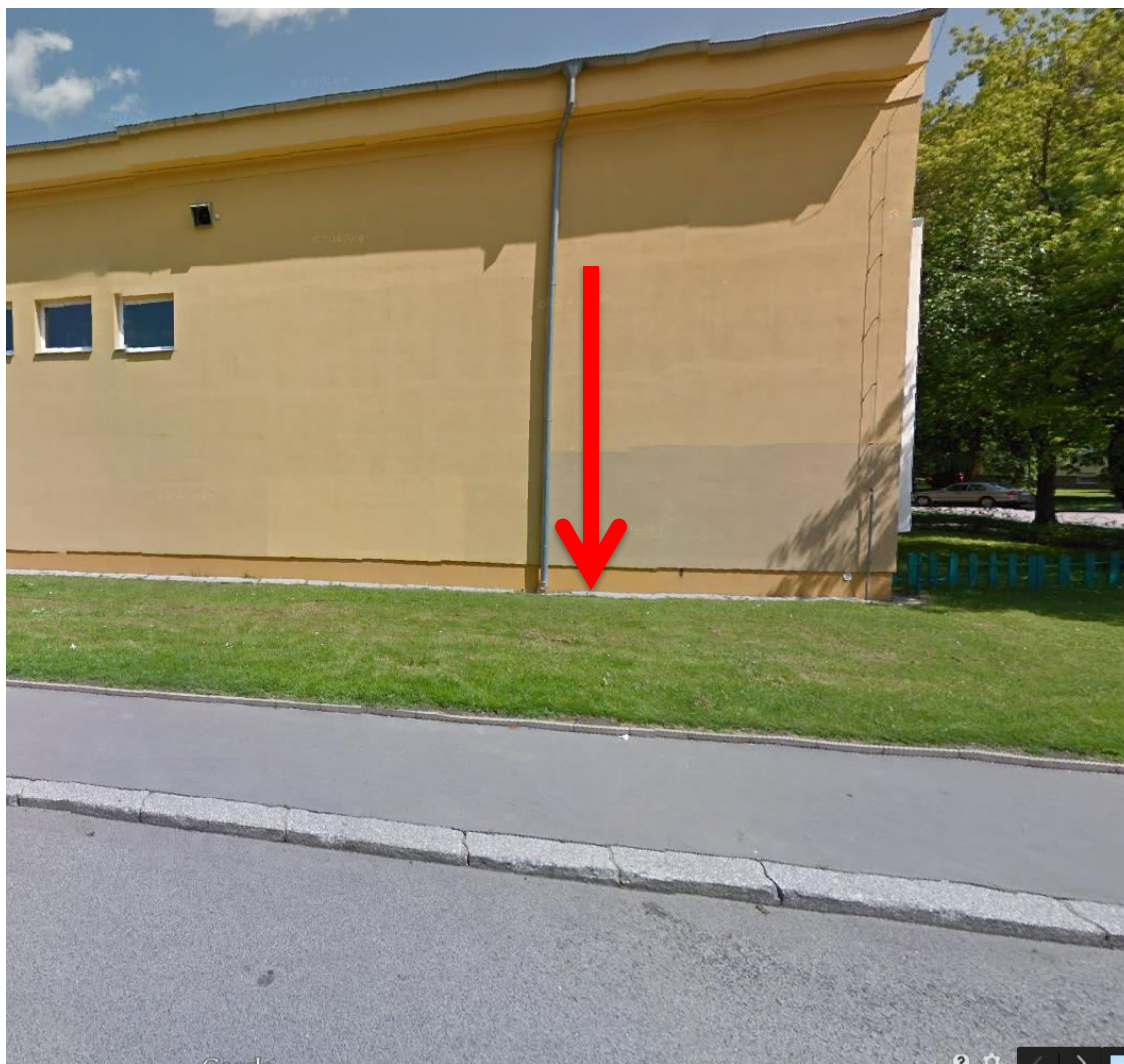
Odvodnění zpevněné střechy Gymnázia nad Alejí, Praha-Petřiny
