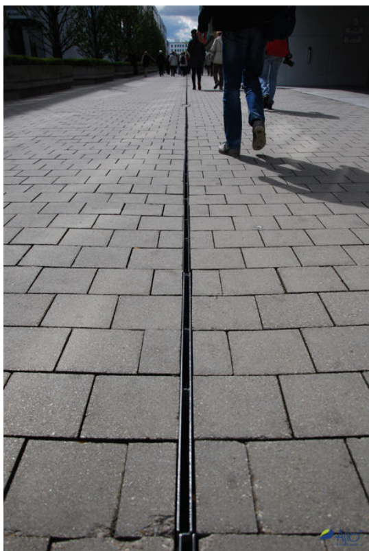
Odvádění srážkové vody na zpevněných plochách
