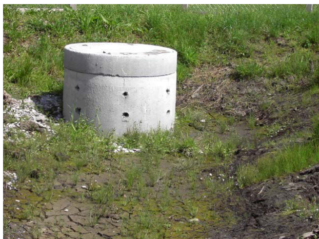
Detail vsakovací šachty
