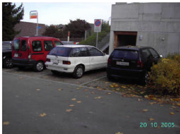
Zatrávněný štěrkový podklad pro venkovní parkoviště
